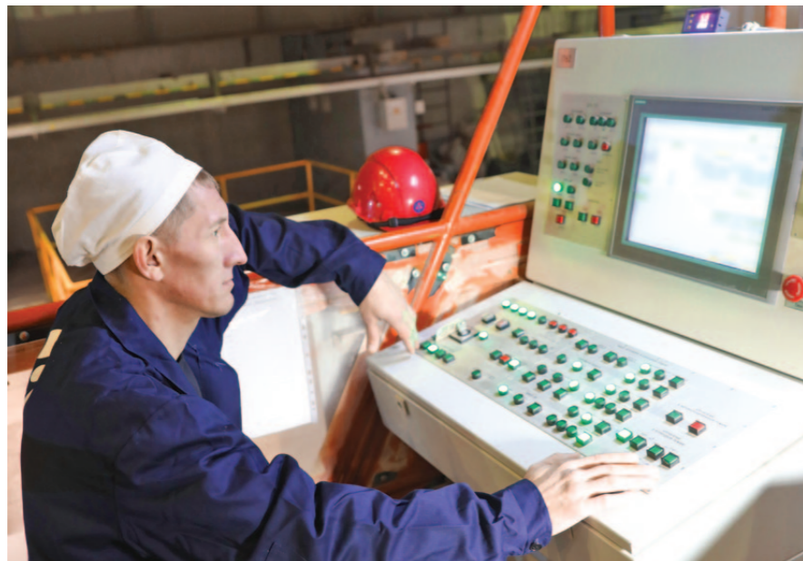
ОПЫТНЫЙ МАШИНИСТ КРАНА АНДРЕЙ УСКОВ НА ПЕРЕГРУЗОЧНОЙ МАШИНЕ ОСУЩЕСТВЛЯЕТ ЗАГРУЗКУ ПЕНАЛА С ОЯТ В ГНЕЗДО ХРАНЕНИЯ
