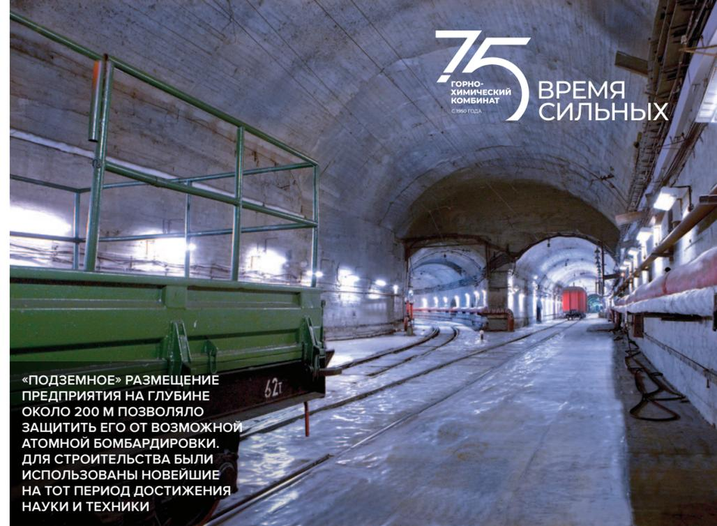
«ПОДЗЕМНОЕ» РАЗМЕЩЕНИЕ ПРЕДПРИЯТИЯ НА ГЛУБИНЕ ОКОЛО 200 М ПОЗВОЛЯЛО ЗАЩИТИТЬ ЕГО ОТ ВОЗМОЖНОЙ АТОМНОЙ БОМБАРДИРОВКИ. ДЛЯ СТРОИТЕЛЬСТВА БЫЛИ ИСПОЛЬЗОВАНЫ НОВЕЙШИЕ НА ТОТ ПЕРИОД ДОСТИЖЕНИЯ НАУКИ И ТЕХНИКИ
